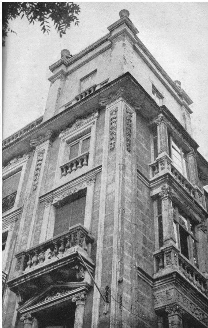
foto del torreón (GGS, 144 dos) desaparecido ya
